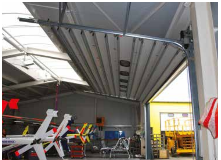
FSL Standardumlenkung mit Dachfolge von 15°
